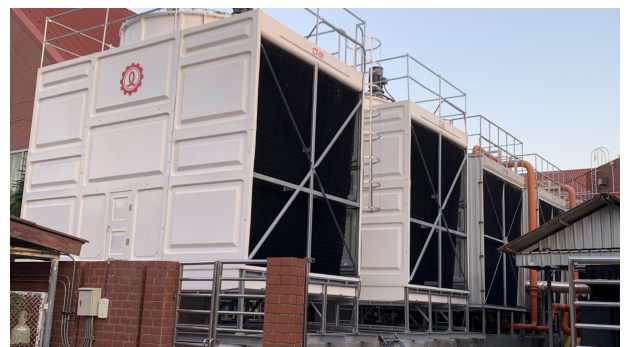
รูปที่ 13 ภาพแสดงการติดตั้งหอผึ่งเย็นใหม่ CT-1,2 ขนาด 600 ตันความเย็น
